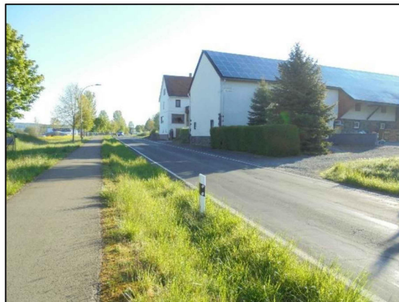
Abb. 8: Westlich im Plangebiet liegender Hof sowie entlang der westlichen Plangebietsgrenze verlaufende Ohmstraße mit Fuß- und Radweg
